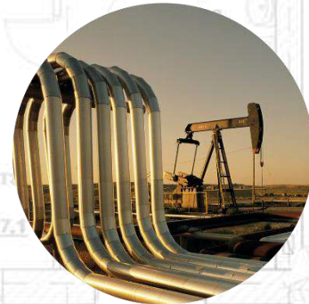
Монтаж технологического оборудования, трубопроводов
