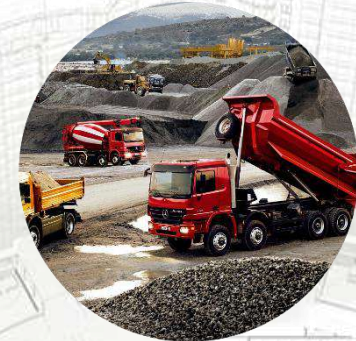
Предоставление специализированной, уникальной строительной и грузоподъемной техники
