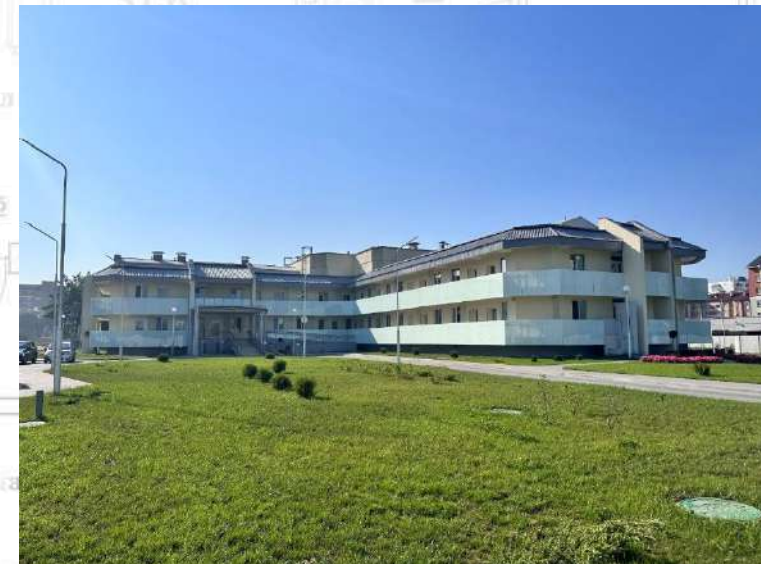
Инфекционный корпус на 80 коек УЗ «Пинская центральная больница»
