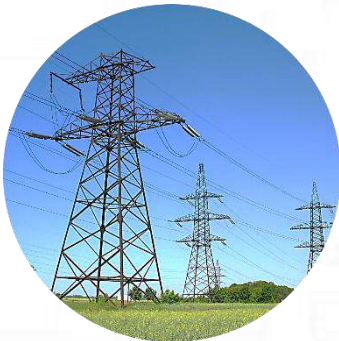
Специализированные работы (электромонтажные, теплоизоляционные, пусконаладочные, ремонтные, сан. технические и др.)
