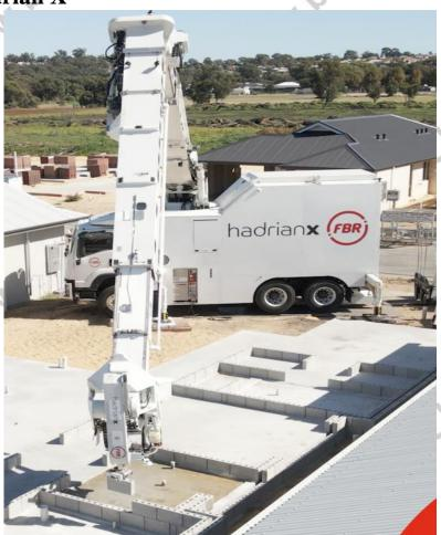
Hadrian  $X^{\text{®}}$  — первая в мире мобильная роботизированная машина и система для укладки блоков, способная безопасно работать на открытом воздухе в неконтролируемых условиях, быстро и точно.
