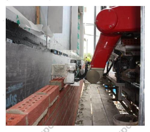
Sam100 — это полуавтоматический робот-каменщик, предназначенный для кладки кирпича с высоким качеством и производительностью. Состоит из конвейера, промышленного манипулятора и насоса для подачи строительного раствора.
