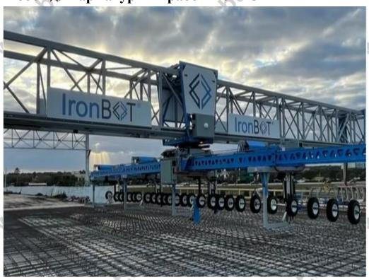
IronBOT предназначен для подъема, переноски, разделения и самостоятельной укладки связок как поперечной, так и продольной арматуры.
