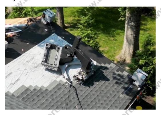
Rufus — автоматизированный кровельный робот, который устанавливает мягкую черепицу со скоростью в три раза быстрее, чем человек-кровельщик.
