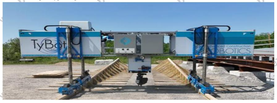
ТуВОТ самостоятельно находит, позиционирует и связывает более 1200 пересечений арматурных стержней в час, не требуя предварительного картирования, программирования или ввода данных ВІМ.
